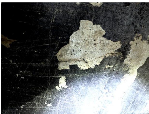
14 pav. Vietomis rūsio perdangos plokštėse susiformavę plyšiai per visą plokštės plotį.
