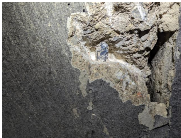
11 pav. Ardančiuoju metodu atidengta rūsio perdangos plokštės armatūra.
