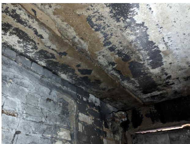
13 pav. Ant rūsio perdangos plokščių matomi drėgmės požymiai.
