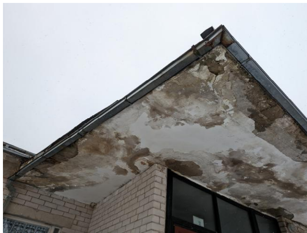
21 pav. Stogelis aptinkuotas, tačiau tinkas vietomis atšokęs ir nukritęs.
